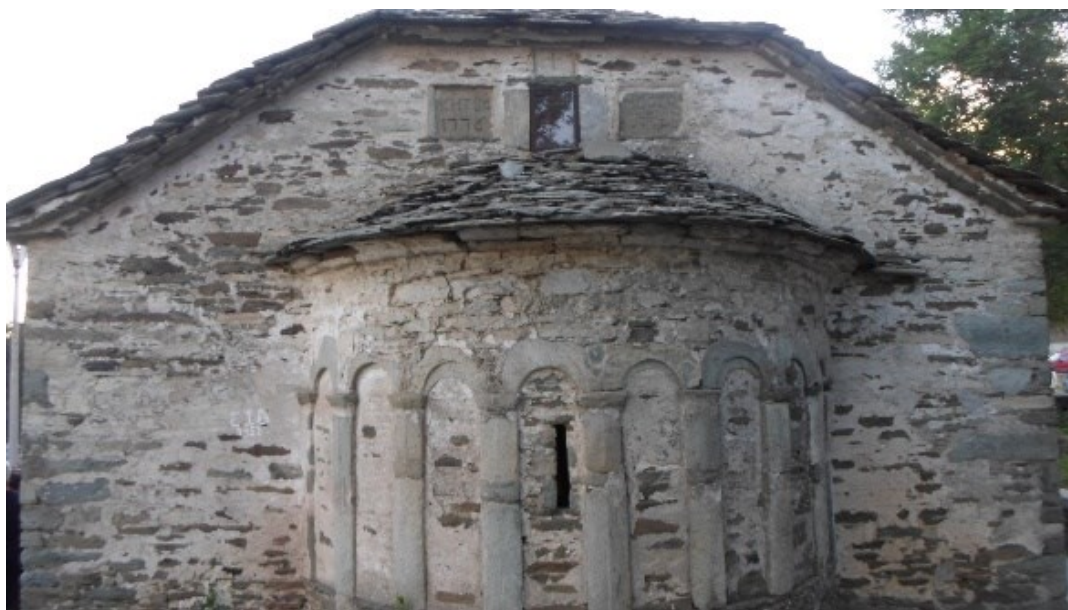
Φ34. Ανατολική όψη (εξωτερική πλευρά κόγχης ιερού) του λιθόκτιστου Καθολικού του παλαιού μοναστηριού Προφήτη Ηλία, δείγμα απέρριπτης καλλιτεχνικής δόμησης με αξιοποίηση αποκλειστικά λαξευτών λίθων τη περιοχής.
