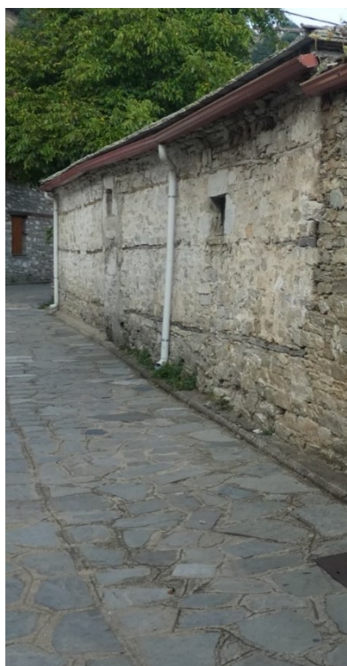
Φ10. Η βορειοδυτική όψη του νοικοκυρόσπιτου Βασκαλή σήμερα. Στο ενδιάμεσο των υδρορροών υπάρχει το ίχνος από την δεύτερη έξοδο διαφυγής με την μεταγενέστερη σφράγιση αυτής της χαμηλής-βοηθητικής εξόδου.
