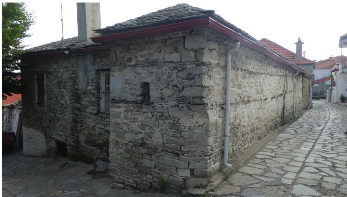
Φ9.Νοικοκυρόσπιτο (αρχοντικό) Βασκαλή σήμερα, με την μικρή χαρακτηριστική εξοχή στη γωνία με την απότμηση, (λόγω προστασίας των φορτίων των ζώων) όπου και το WC, και τις τρεις σειρές ξυλοδεσιές
