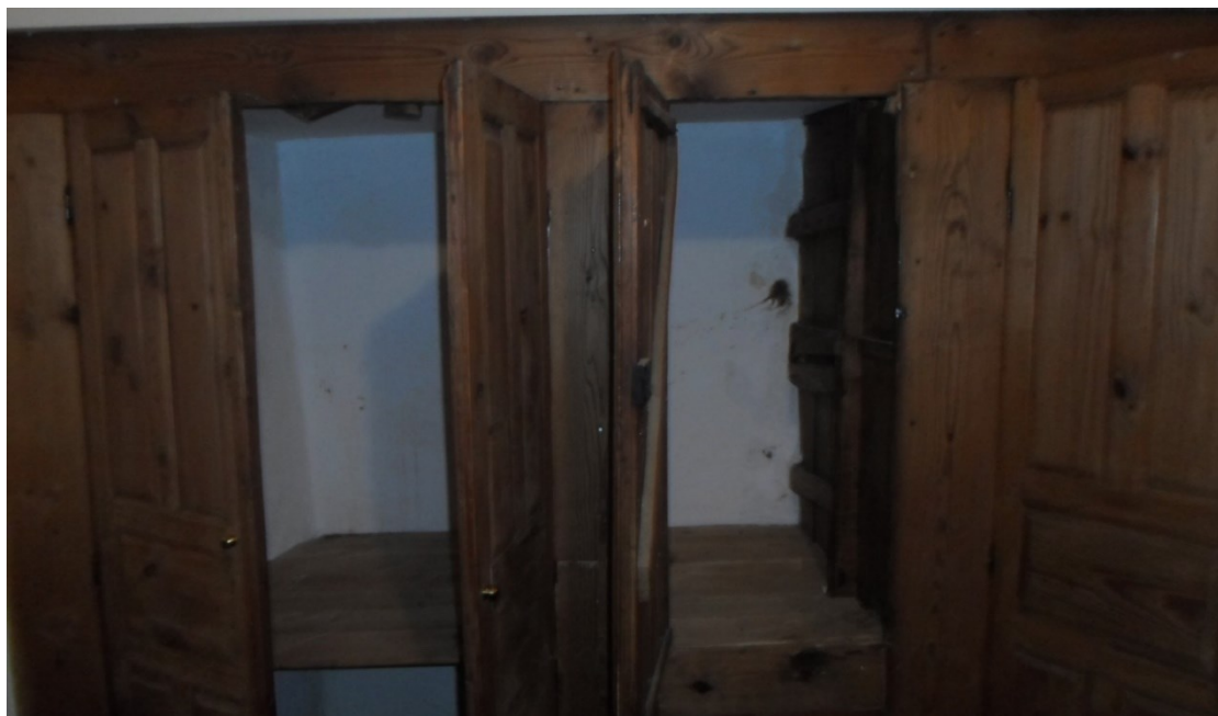
Φ41. Νοικοκυρόσπιτο (αρχοντικού) Βασκαλή: Η Μεσάντρα ή μισάντρα του μεγάλου υπνοδωματίου, ξύλινο επιμήκες ερμάριο με χωρίσματα και ταμπλαδοτές πόρτες, φύλαξης κλινοσκεπασμάτων χαλιών κλπ οικιακού εξοπλισμού
