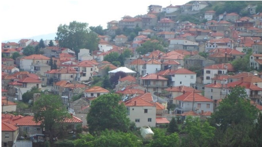
Φ23. Το Λιβάδι σήμερα: Άποψη τμήματος του οικισμού με εμφανή τα δομικά χαρακτηριστικά της σύγχρονης οικοδόμησης
