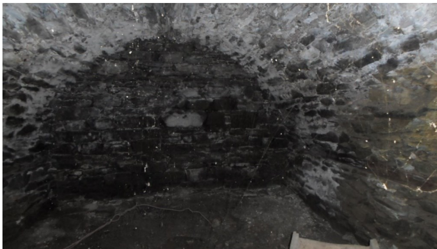
Φ19. Χαρακτηριστικός πετρόκτιστος και περικλειστος «θόλος» (όπως τους ονομάζουν στο Λιβάδι) δηλ. υπόγειοι ή ημιυπόγειοι χώροι έκτακτης ανάγκης και προστασίας. (Θόλος του νοικοκυρόσπιτου Βασκαλή
